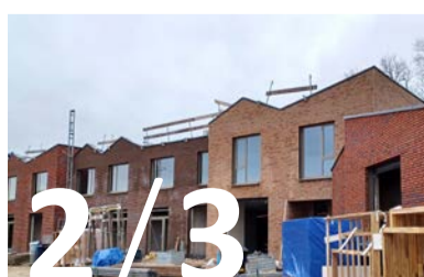
2/3 Hazelaar en Esdoorn in aanbouw
